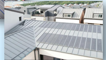
건물, 벽면일체형 태양광 (BIPV, BAPV)
